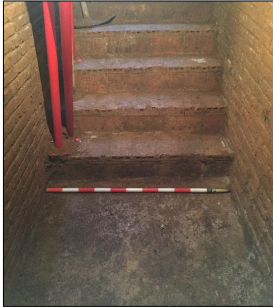
Tercer replà i els sis esglaons que donen accés al tapiat del refugi.
