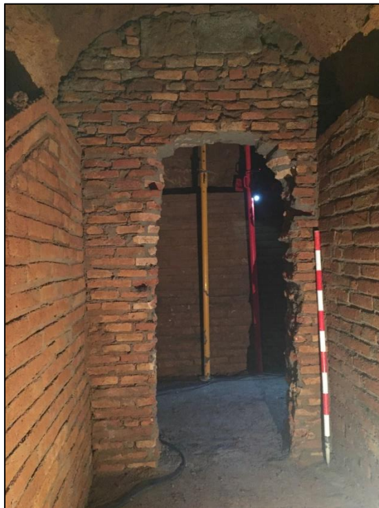
Vista de l'obertura en el tapiat (UE 12), des de la part interior.
