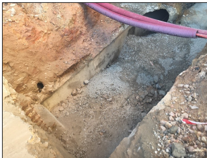
Fig. 12. Inici de la rasa 2, en el punt de connexió del nou col·lector amb el vell.
