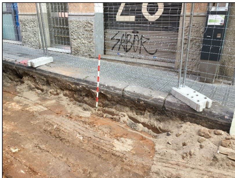
Fig. 40. Detall del rebaix en relació el nivell de vorera del carrer Concòrdia.
