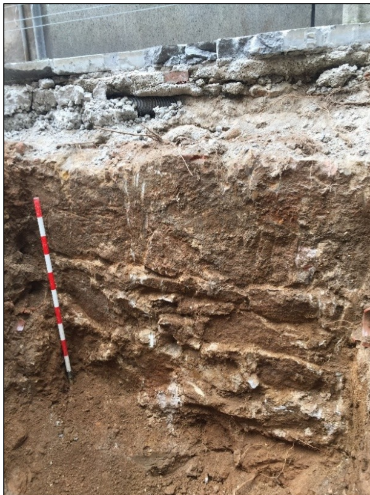
Fig. 43. Mur (UE 35) i nivell on s'assenta el mateix (UE 36), a l'extrem est de la rasa 4.
