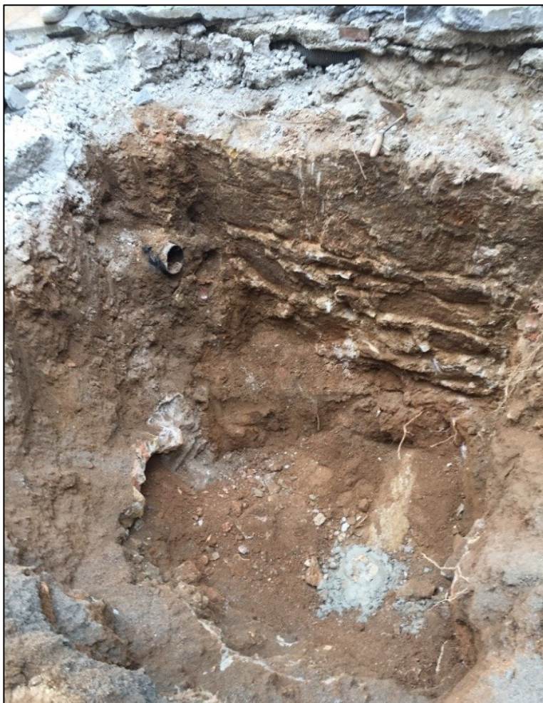
Fig. 42. Vista de la rasa 4, un cop concloua. S'aprecia el mur ( UE 35 ) i l'antic col·lector ( UE 33 ).
