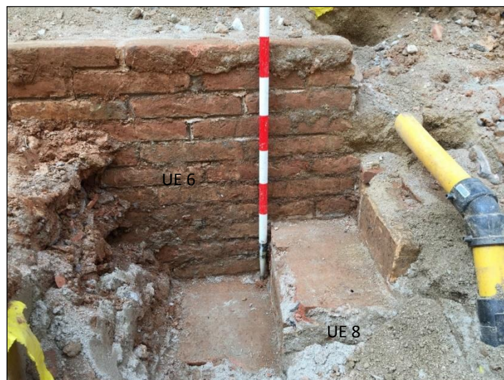
Parament constructiu en maó dels murs de l'accés al refugi.
