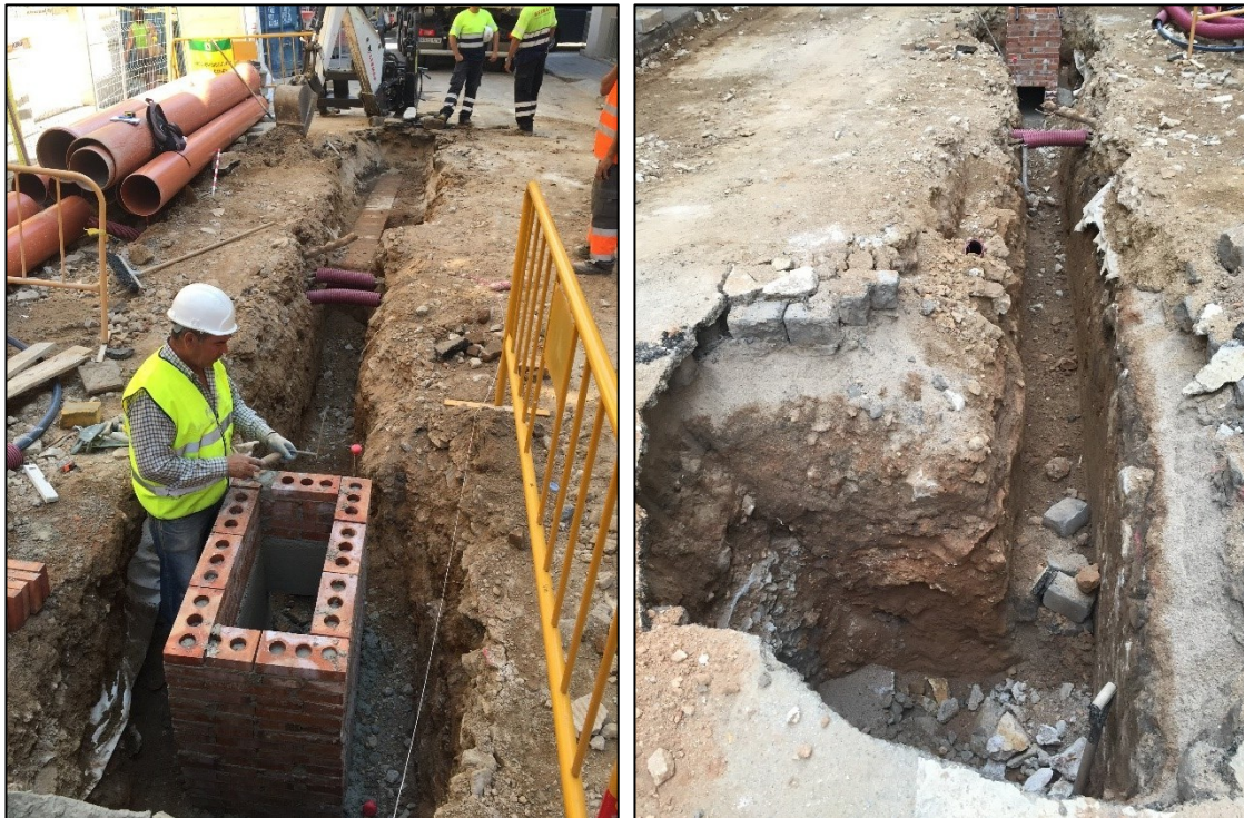
Fig. 62-63. Rasa 11 en primer lloc vista des del sud, amb la primera caixa del embornals i seguidament vista des del nord, on s'aprecia el mur UE 22.
