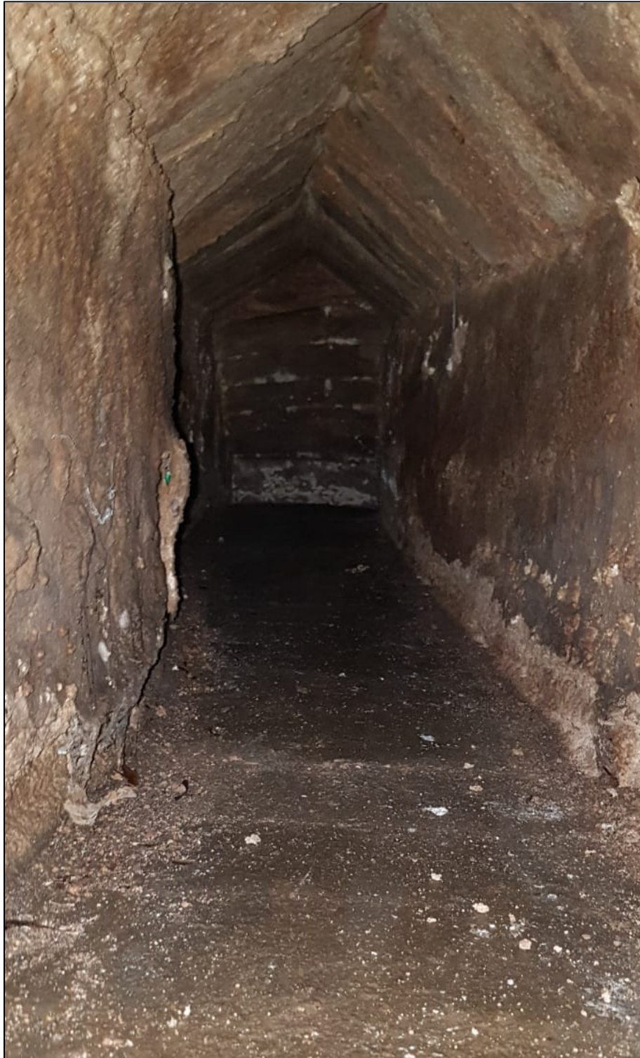
Fig. 38. Conducció en falsa volta d'arc apuntat que es creia que donava accés a la volta del refugi al fons (Font: Crobiser)
