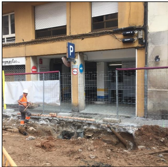
Localització de la rasa 6 i presència del mur de façana (UE 35).
