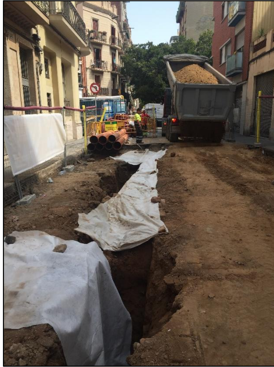
Tapat de les estructures de l'extrem nord de l'obra (UE 22 i 23) amb geotèxtil i cobertes amb sauló.
