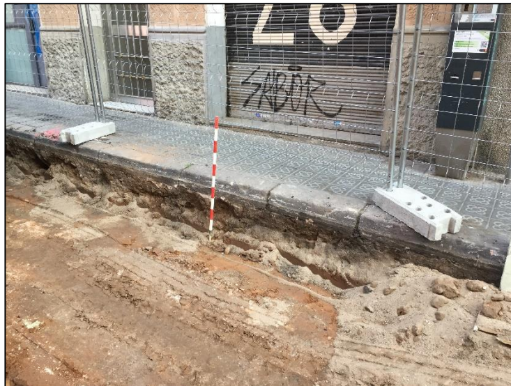
Detall del rebaix en relació el nivell de vorera del carrer Concòrdia.
