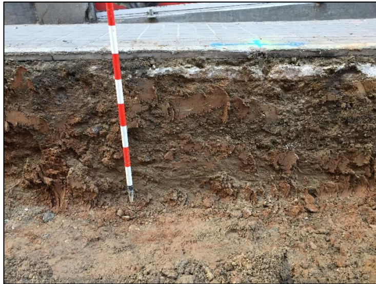
Rebaix realitzat en la caixa de transit rodat del carrer Radas.
