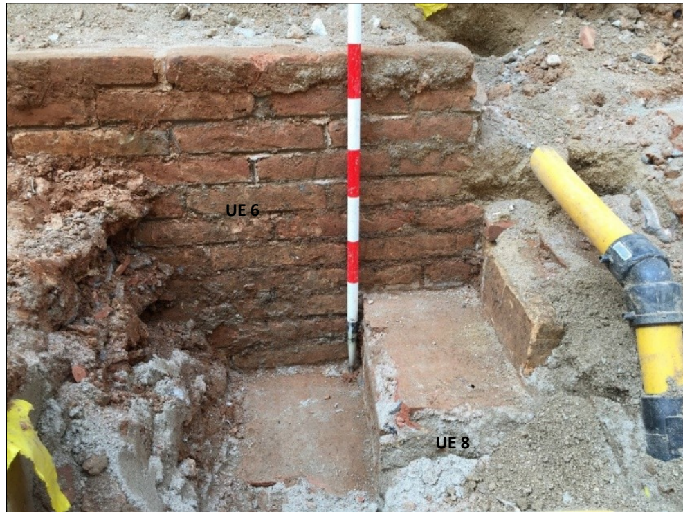
Fig. 17. Parament construït en maó dels murs de l'accés al refugi.
