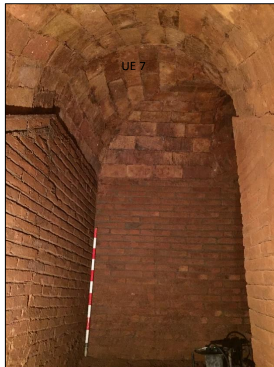
Volta UE 7, en el punt que les escales donen accés al refugi.
