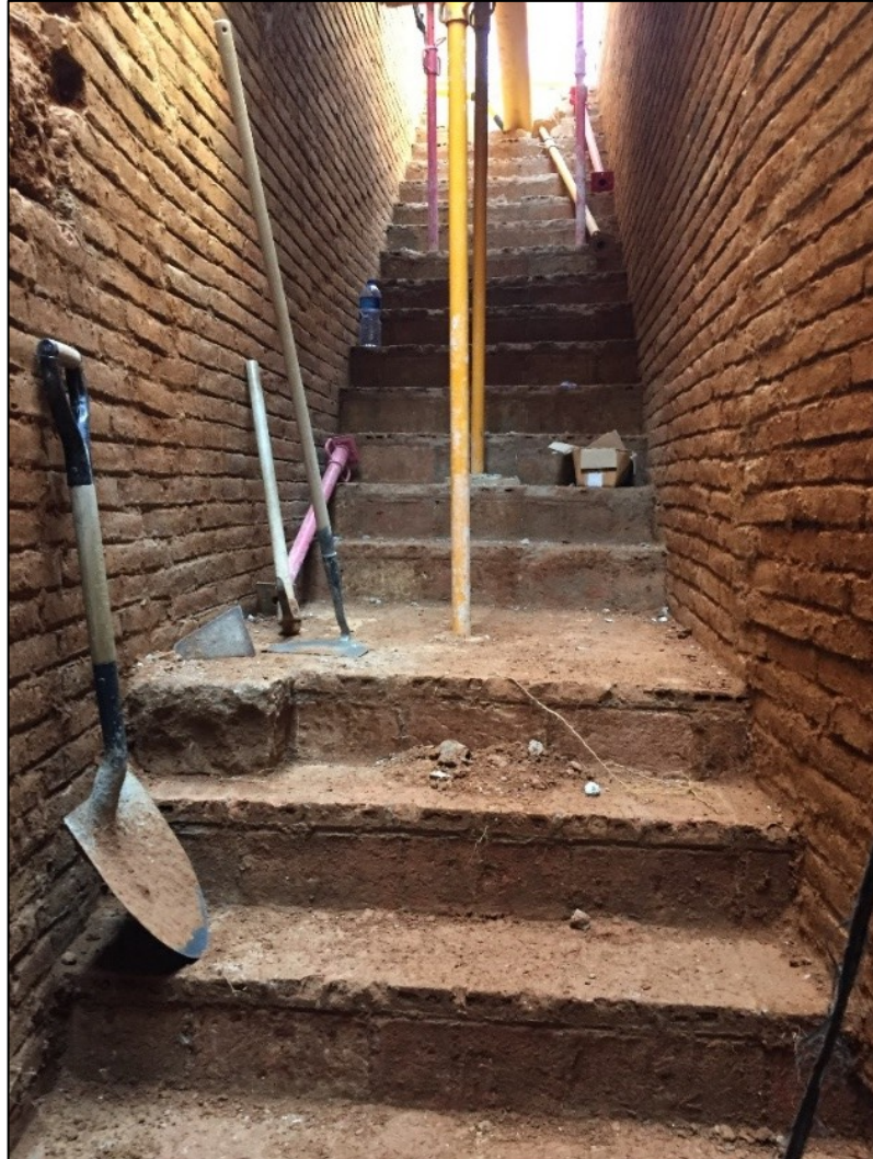
Fig. 21. Primer tram d'escapes, replà i els primers esglaons del segon tram.
