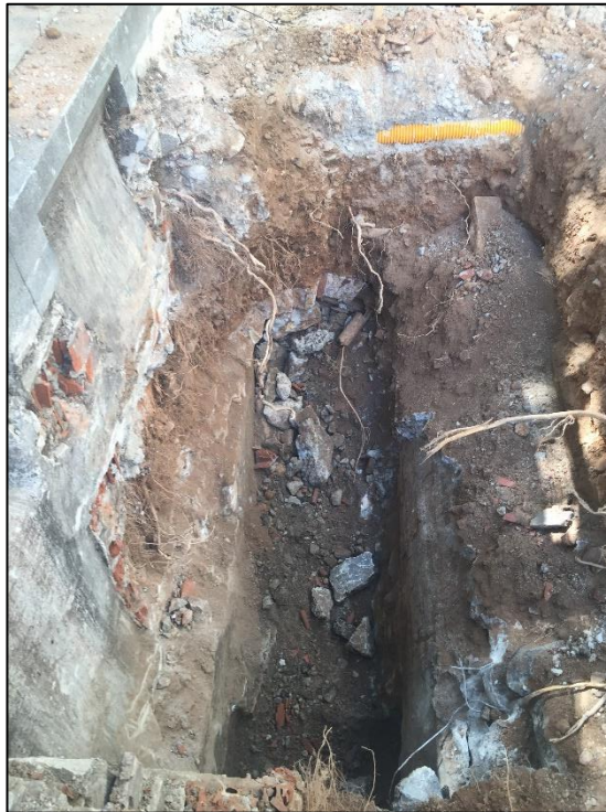
Vista de la rasa 3, un cop conclusa, en que es pot apreciar la part alta de l'antic embornal, així com el col·lector i l'estructura amortitzada al seu costat.
