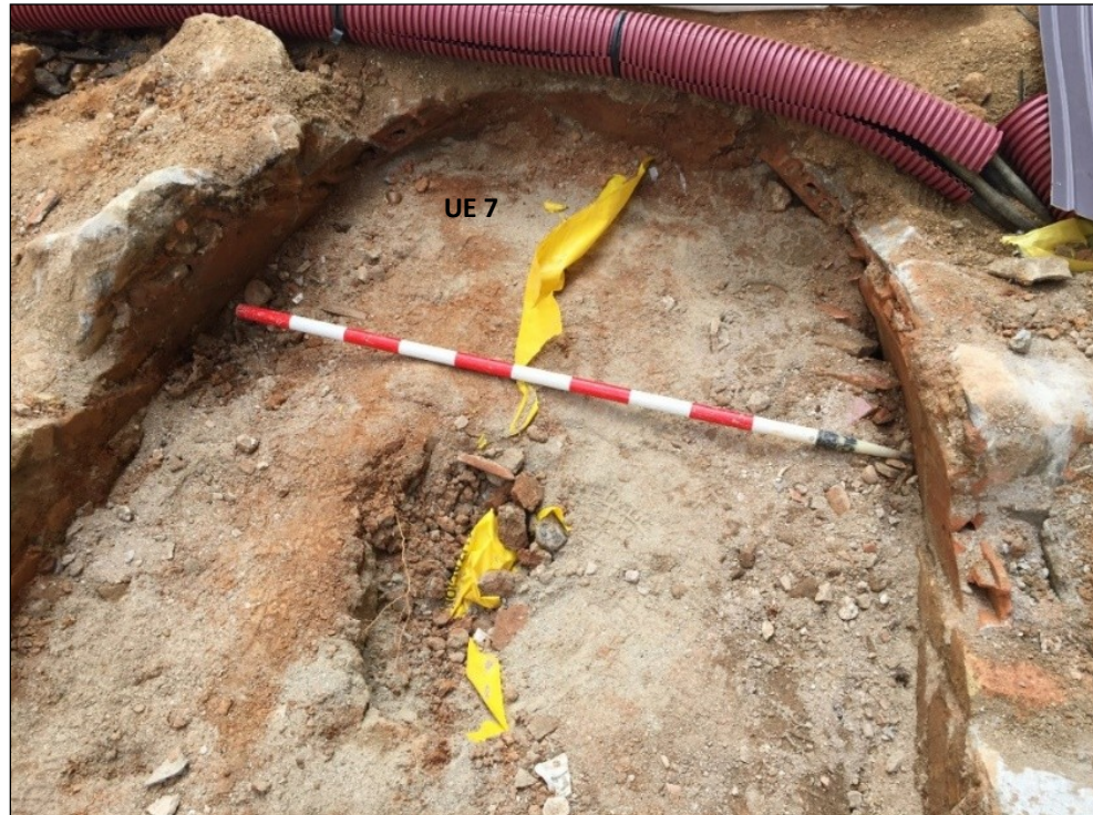
Fig. 18. Evidència de la volta d'entrada, trencada per la canalització del gas.
