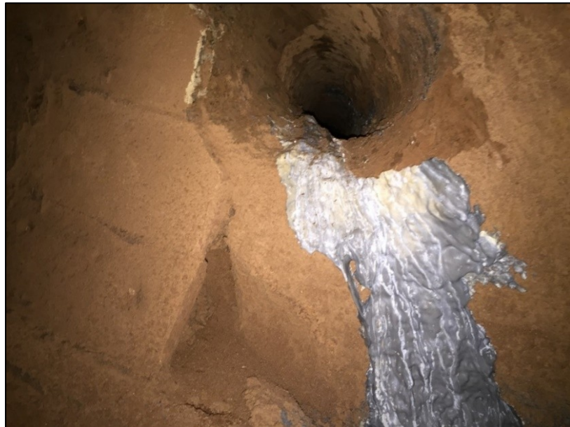
Fig. 35. Forat realitzat en el costat del mur UE 5, però que creua l'accés i perfora també el mur UE 6.
