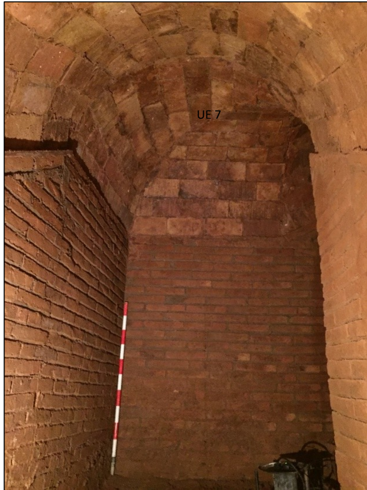
Fig. 31. Volta UE 7, en el punt que les escales donen accés al refugi.
