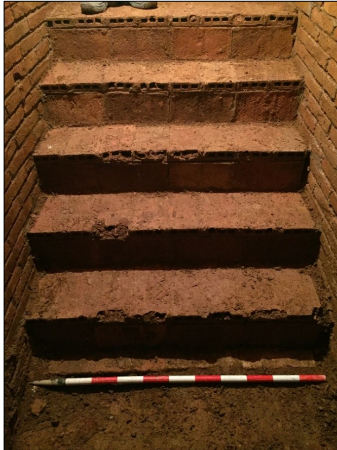
Fig. 29. Últims cinc esglaons construïts i cinquè replà, aquest ja de terra
