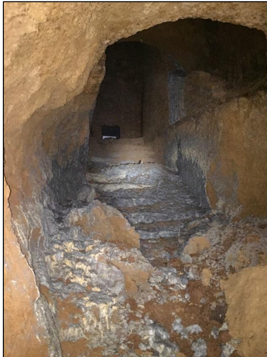
Part de la zona d'afectació del ciment líquid injectat en la construcció del garatge.
