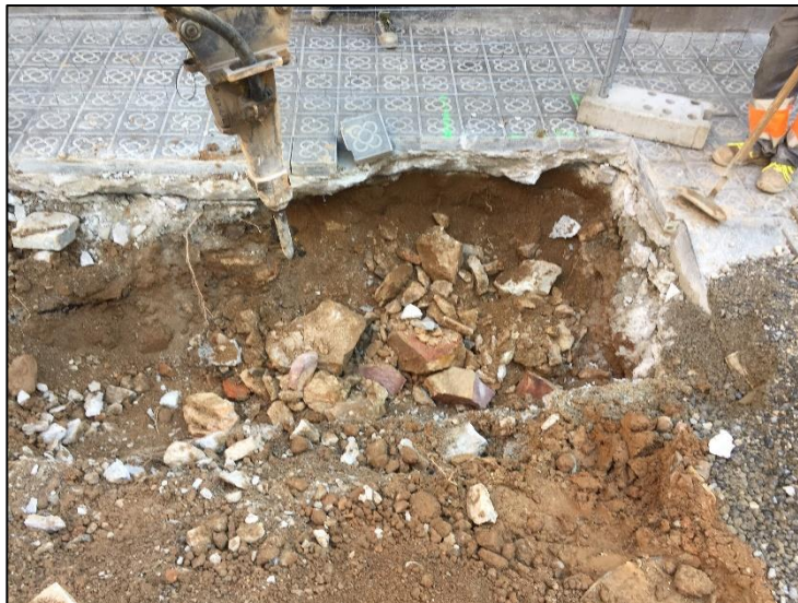
Desmuntatge del mur UE 35 per situar la caixa de l'embornal.
