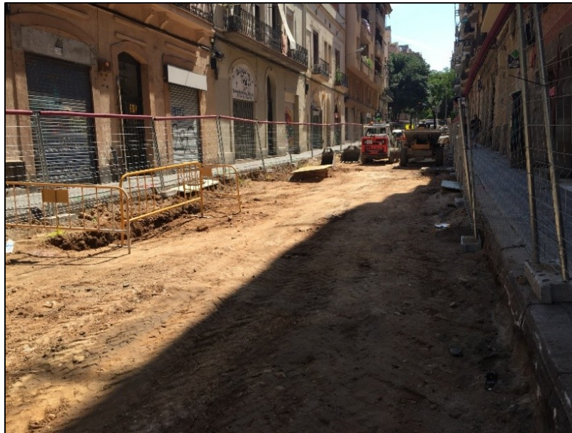
Fig. 39. Rebaix de la caixa del carrer a la zona central del carrer de la Concòrdia.
