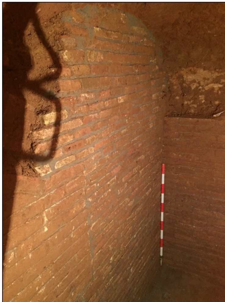
Fig. 26. Mur del tapiat del refugi (UE 12) .
