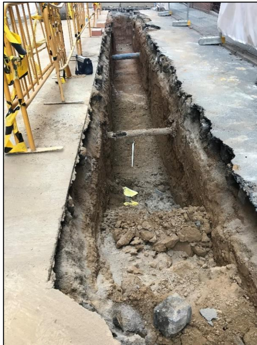
Localització de la Roca Natural a 1,8 metres sota el nivell de vorera del carrer.
