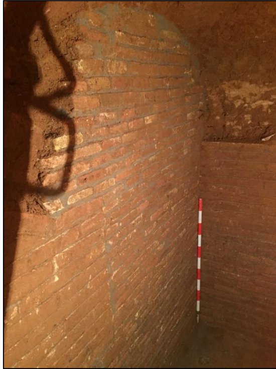
Mur del tapiat del refugi (UE 12).
