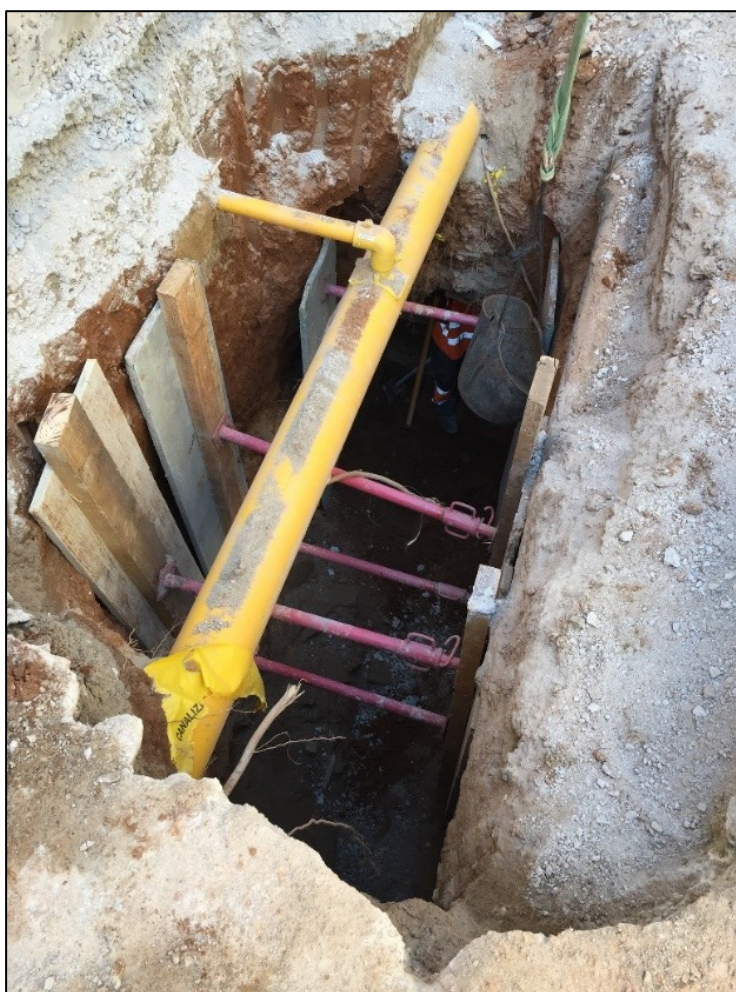
Fig. 20. Rasa de sanejament de l'accés al refugi.
