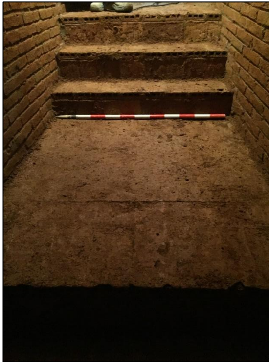
Tres esglaons i replà posteriors a la zona de tapiat del refugi.
