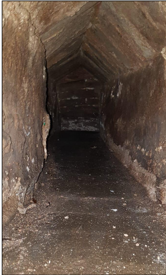
Conducció en falsa volta d'arc apuntat que es creia que donava accés a la volta del refugi al fons (Font: Crobiser).
