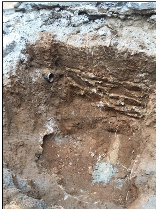
Vista de la rasa 4, un cop conclusa, en que es pot apreciar el mur (UE 35) i l'antic col·lector (UE 33).
