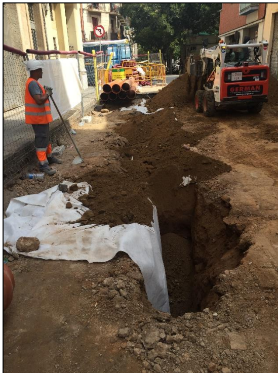
Tapat definitiu de les rases 7 i 8 i les estructures UE 22 i 23 a partir de sauló.
