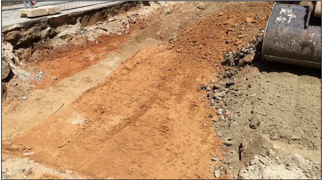
Fig. 6. Rebaix realitzat en la caixa de transit rodat del carrer Radas.
