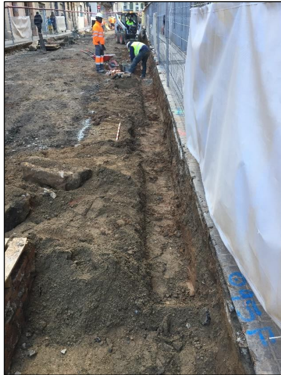
Rasa 1 en relació al rebaix del carrer Radas.
