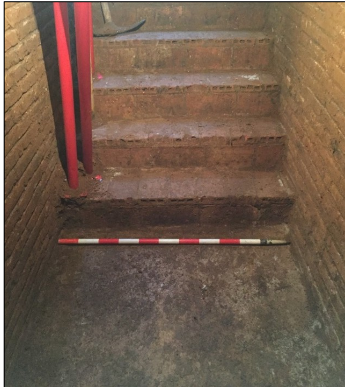
Fig. 24. Tercer replà i els sis esglaons que donen accés al tapiat del refugi.
