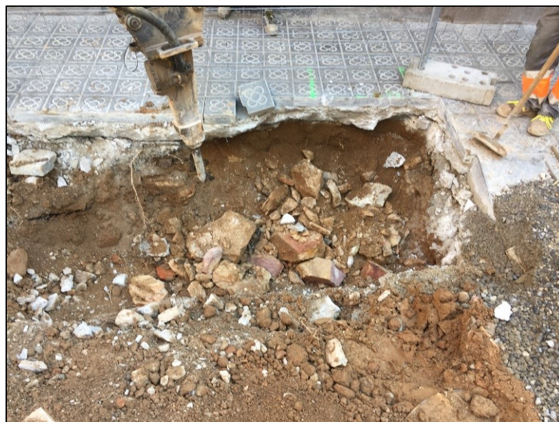
Fig. 46. Desmuntatge del mur UE 35 per situar la caixa de l'embornal.
