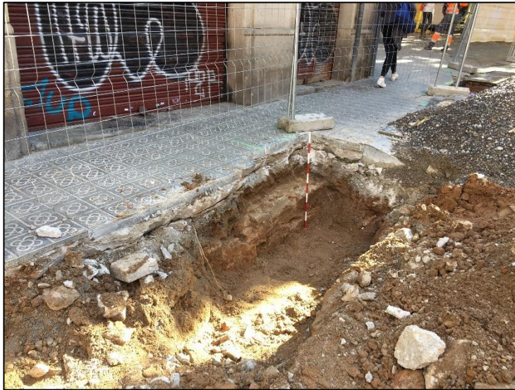
Localització de la rasa 5 davant del núm. 21 del Carrer de la Concòrdia. Es pot veure el mur UE 35 .
