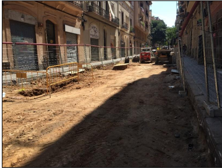
Rebaix de la caixa del carrer a la zona central del carrer de la Concòrdia.
