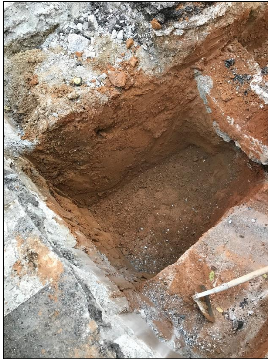
Inici de la rasa 2, en el punt de connexió del nou col·lector amb el vell.
